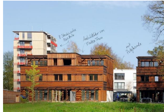
„City of Wood“, B&O Bau Forschungsquartier © Huber&Sohn
